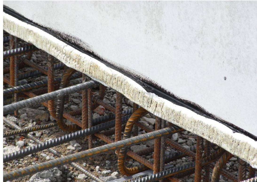
Arbeitsfugenabdichtung mit Anschlussbewehrung
